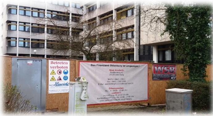
Betreten verboten: Das ehemalige Gebäude des Finanzamtes Oldenburg steht vor dem Abriss.
